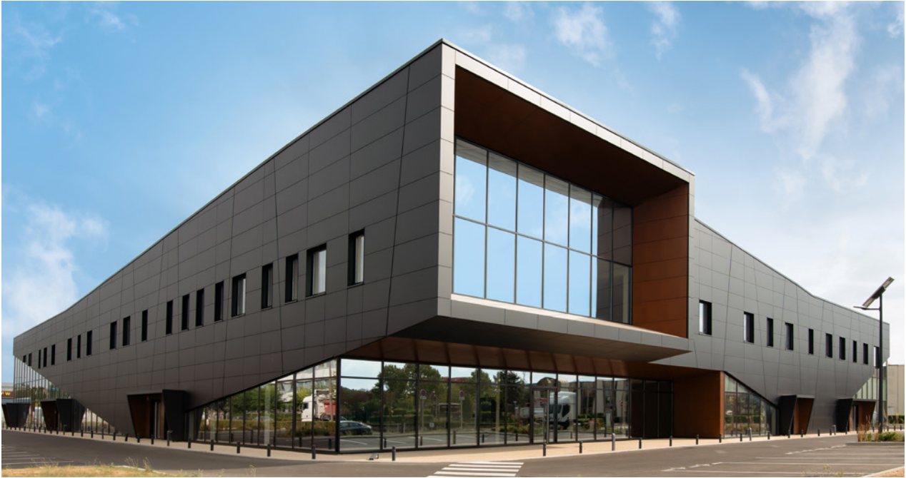
Bonneuil Sur Marne | office complex | France | STB-425
