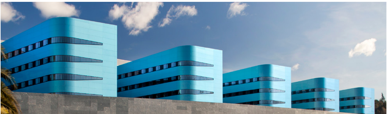
Hospital Álvaro Cunqueiro | Vigo, Spain | STB - 468
