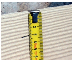
③ Recouvrement de 30 mm
